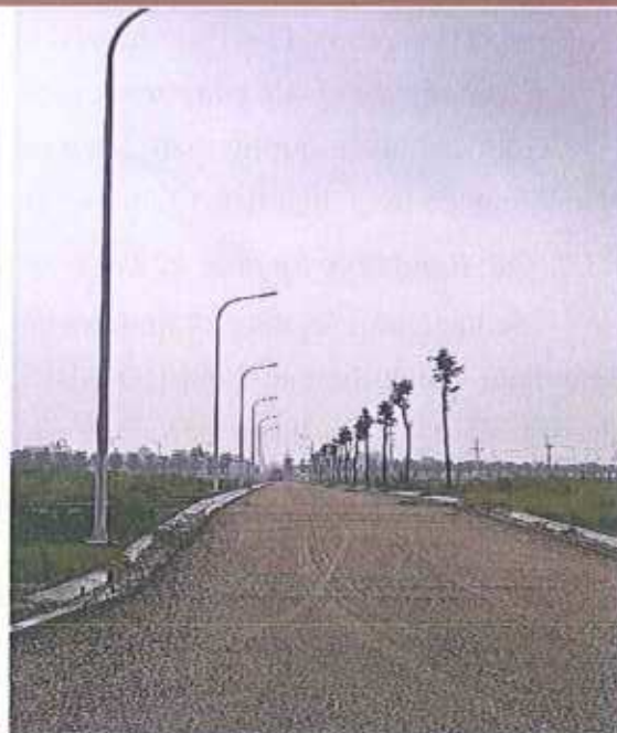
Hình ảnh tuyến đường nội bộ đang thi công và khu vực cây xanh
